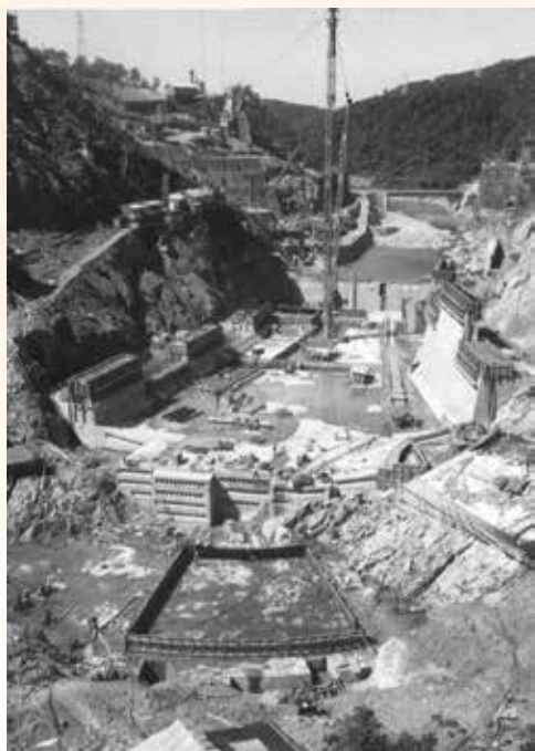
天ヶ瀬ダム建設
