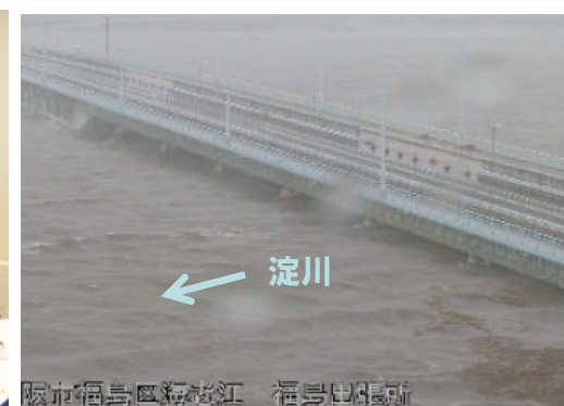
参考：平成30年台風第21号 上陸時の淀川大橋付近の状況
