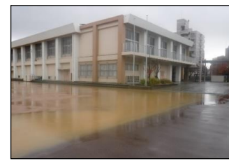
雨水流出抑制施設(校庭貯留)
