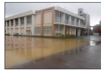
雨水流出抑制施設(枝庭貯留)
