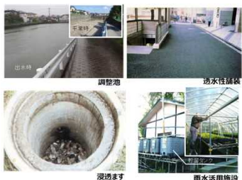
雨水貯留浸透施設の例
