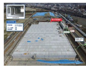
雨水貯留施設(安満遺跡公園)
