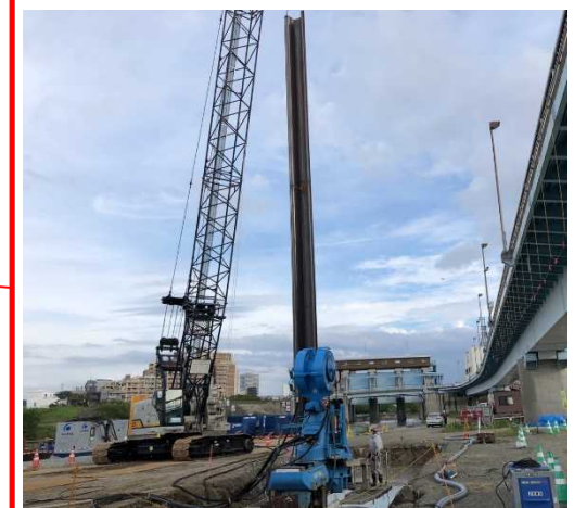
閘門を造るための仮締切矢板施工
