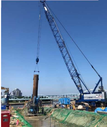
導水路の鋼管矢板施工
