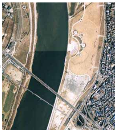
枚方大橋上流 (河川改修後)
