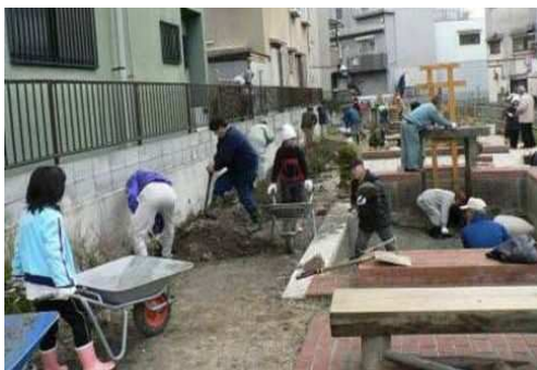
写真-11 市民工事
