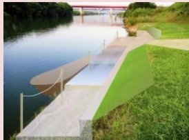
背割堤船着場(3月完成)
