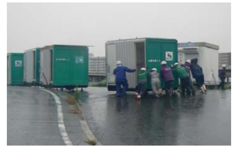
トイレ・管理所の施設撤去(太子橋地区)
