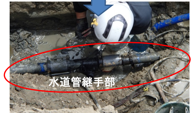
水道管の継手部から漏水が確認。 ⇒継ぎ手部の交換により復旧
