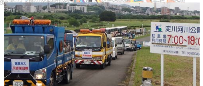
駐車場から復旧現場へ向かう車列
