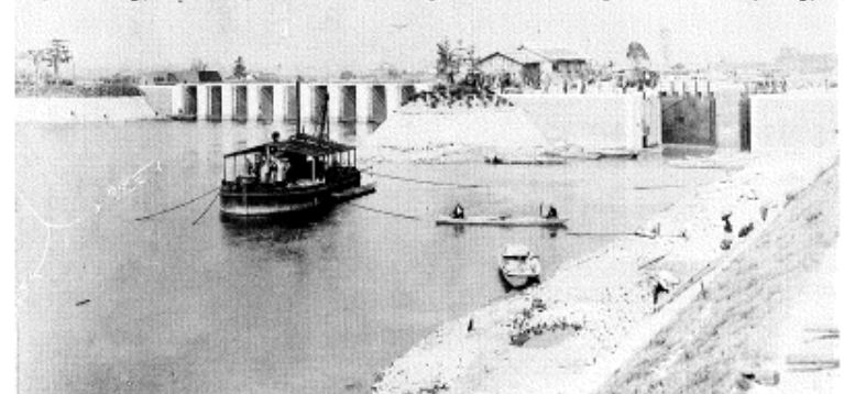
【毛馬洗堰・閘門全景(明治43年)】
