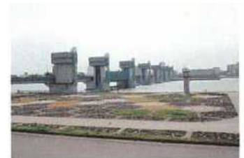
毛馬の排水機場と閘門 甲子園を 30 分で満水にする
