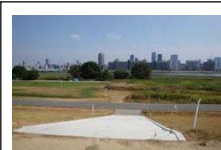
④ 堤防道路からのアクセス
