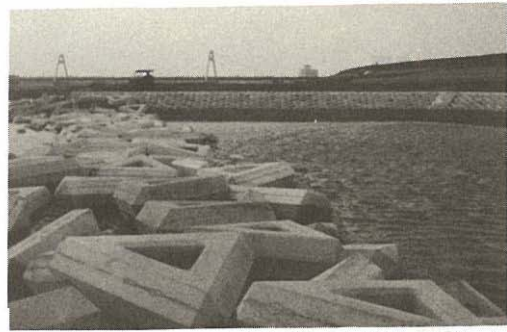
図2 大道町人工ワンドと本流を隔てる中空テトラポット
