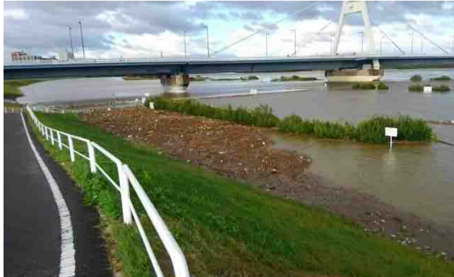
水位上昇し、公園が冠水(太子橋地区)
