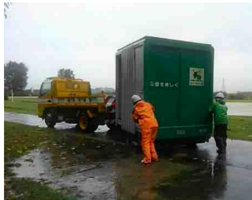
公園施設撤去風景(大山崎地区)
