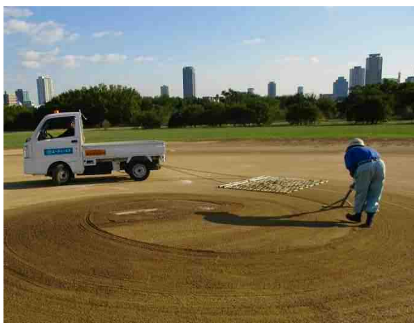
運動施設の復旧状況(西中島地区)
