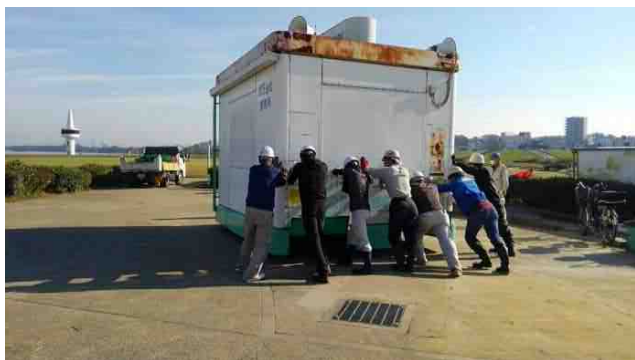
管理所の復旧状況(枚方地区)
