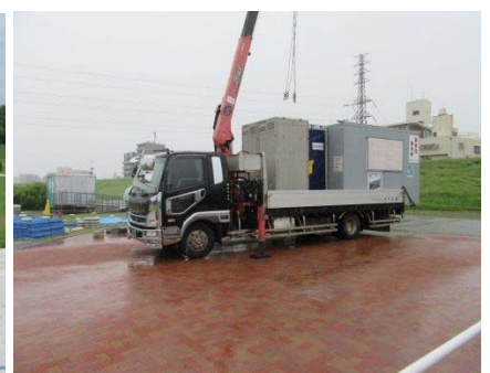
平成30年台風24号による出水準備として行われた有料BBQエリア関連施設の撤去作業（作業経費に宅配BBQサービスで得られた収益の一部を活用）
