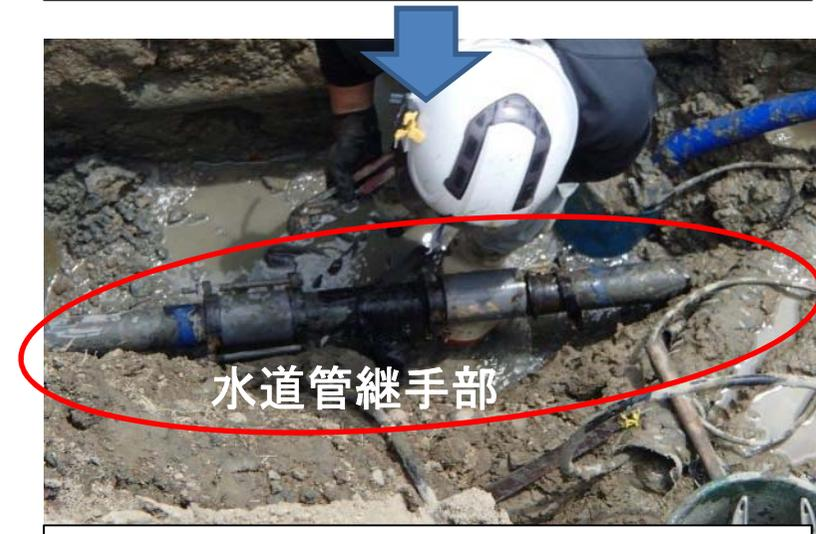
水道管の継手部から漏水が確認。
