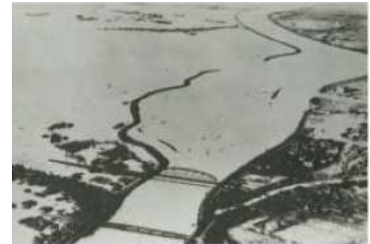
昭和28年の洪水による宇治川左岸堤防決壊(向島地先)
