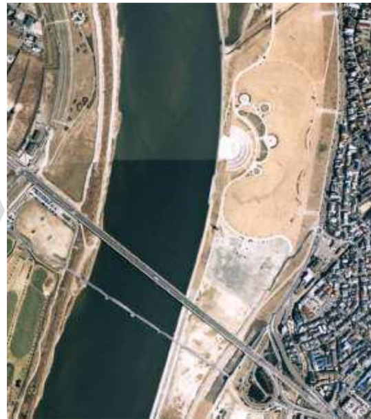
枚方大橋上流 (河川改修後)
