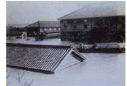
高槻市三島江兵衛の洪水状況
