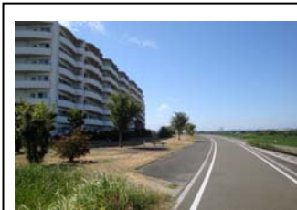
④ 堤防道路沿いの緑地
