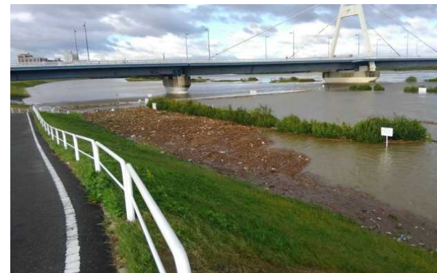
水位上昇し、公園が冠水(太子橋地区)
