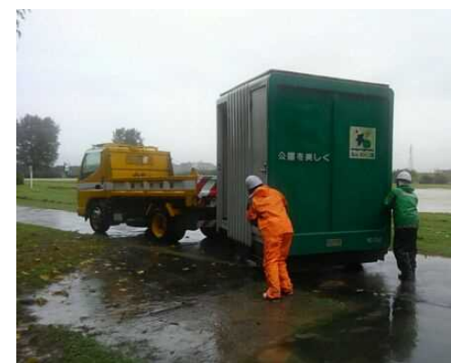
公園施設撤去風景(大山崎地区)
