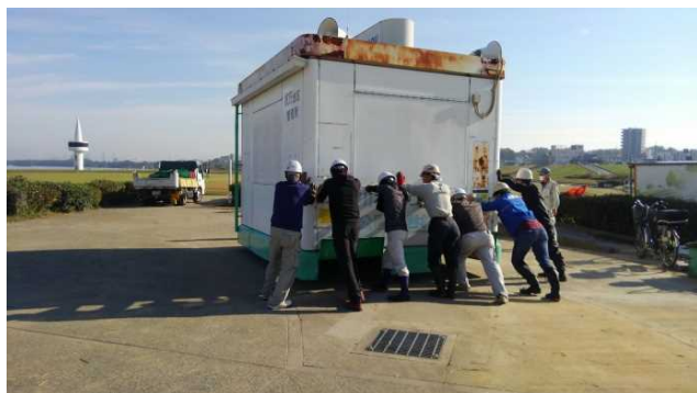
管理所の復旧状況(枚方地区)
