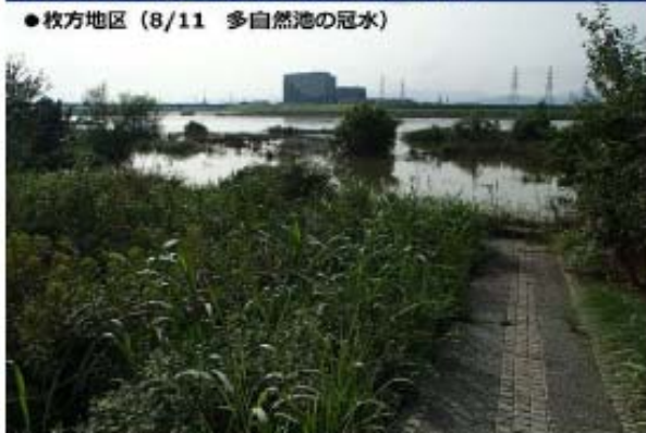
平成26年8月水害による淀川河川公園の被災状況 6
