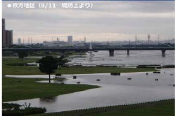
平成26年8月水害による淀川河川公園の被災状況 7
