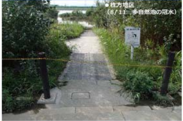
平成26年8月水害による淀川河川公園の被災状況 5
