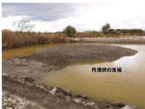
造成した浅場(ワンド中央上流側, H18.12.10)
