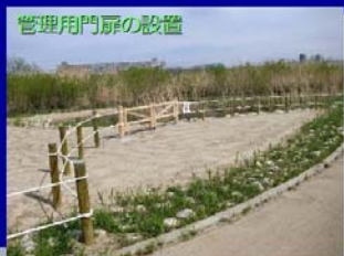
管理用門扉の設置
