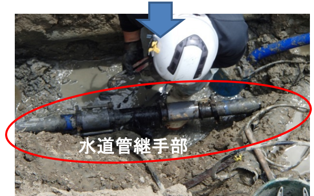
水道管の継手部から漏水が確認。 ⇒継ぎ手部の交換により復旧
