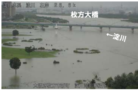
水位上昇し、公園が冠水(枚方地区)
