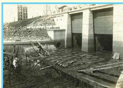
建設中の三栖洗堰
