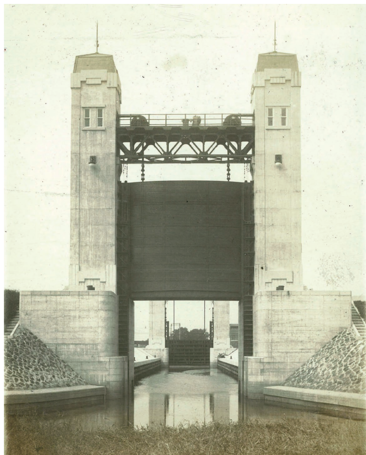
三栖閘門 1929(昭和4)年3月
