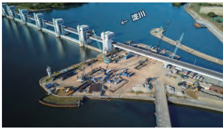
こうもんこうやいただせつ 閘門鋼矢板打設(令和4年10月)(着工:令和3年11月)
