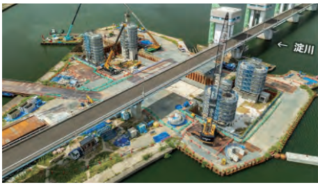
こうもんもんちゅうだせつ 閘門の門柱打設(令和6年9月)
