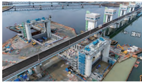
ゲートの開閉装置設置(令和7年2月)
