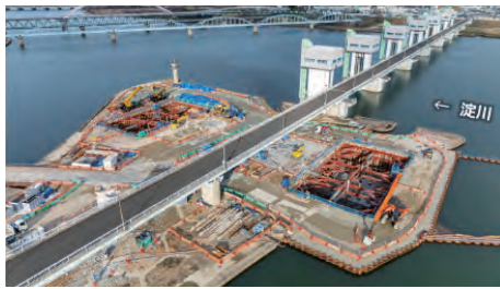
こうもんないくつきく 閘門内の掘削(令和6年2月)
