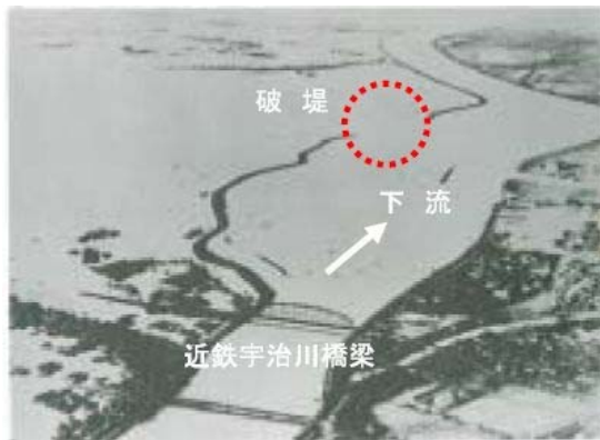
図 1.1-16 破堤状況 資料 1-13
