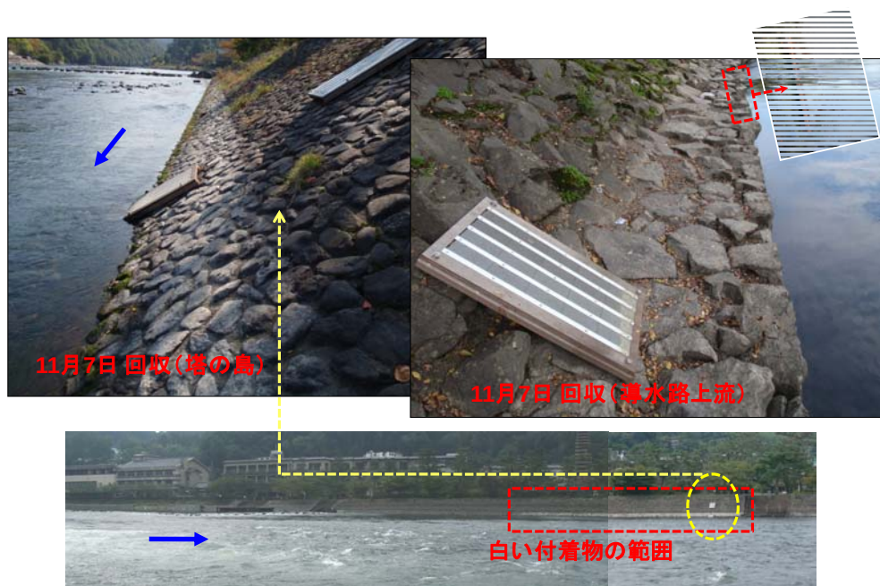
図 5.3-45 付着板設置状況
