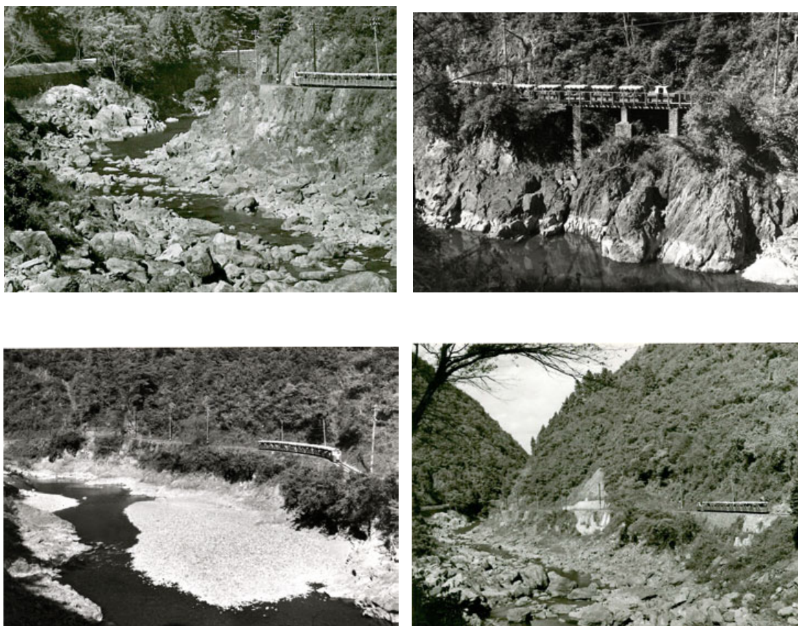
写真 2.1-1 天ヶ瀬ダム建設以前の河道状況
