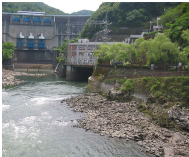
写真 2.2-2 天ヶ瀬発電所
