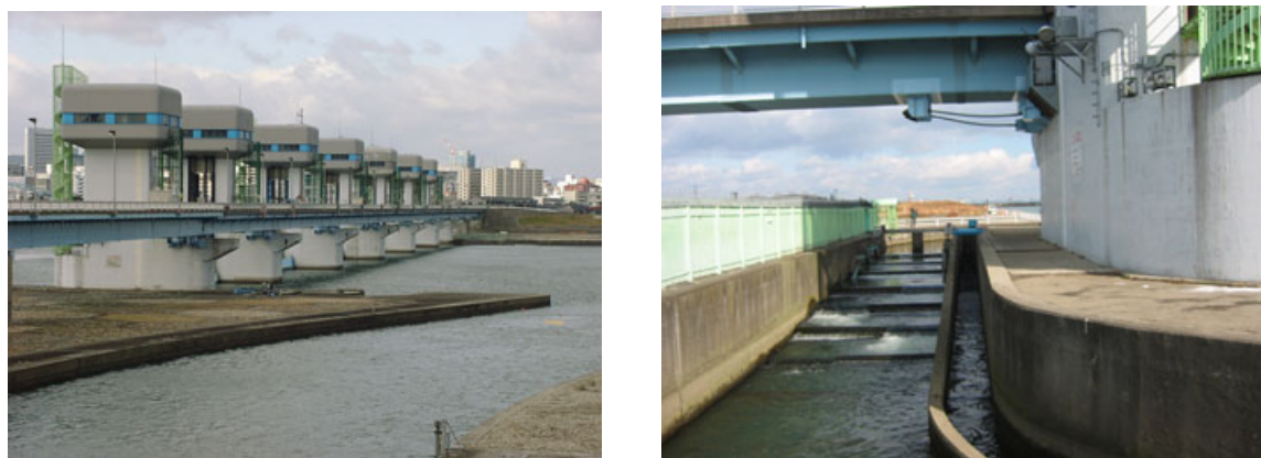
写真 2.3-3 淀川大堰概観 (左：左岸上流より 右：右岸魚道)
