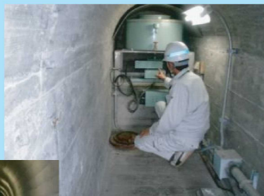
たわみ計確認状況
