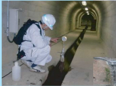
漏水量計測状況
