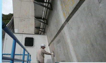
ダム構内巡視状況
