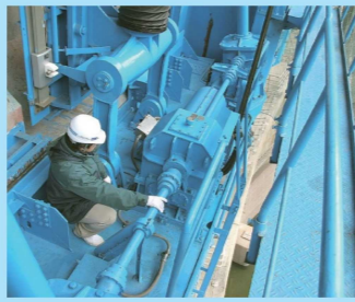
ゲート点検状況
