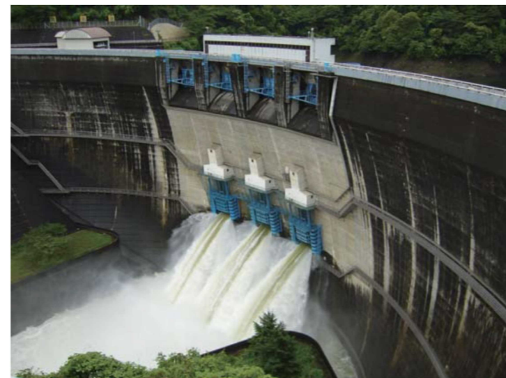
天ヶ瀬ダムからの放流
