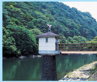
槇尾山水位観測所
