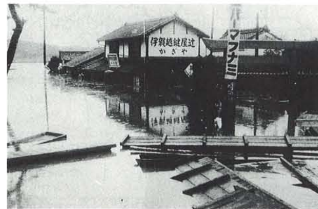
木津川支川服部川の氾濫により軒下まで浸水(上野市、1961年)
