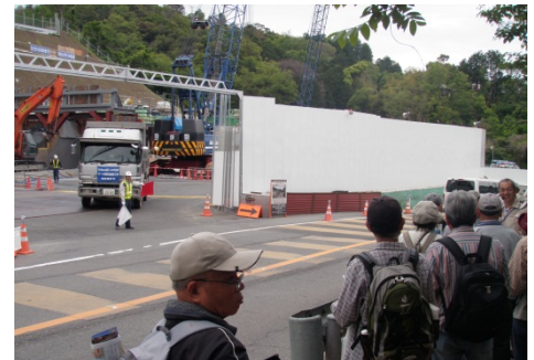
天ヶ瀬ダム再開発事業ゲート室工事現場
