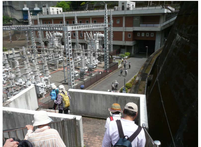
天ヶ瀬発電所を通り抜け、いよいよ天ヶ瀬ダムの真下へ
