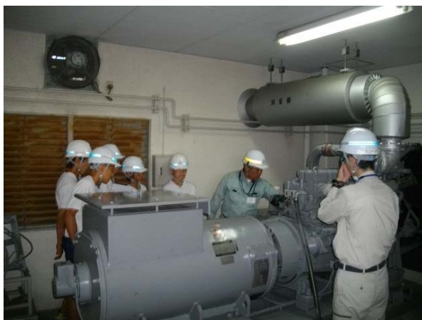
③ダム本体の点検
