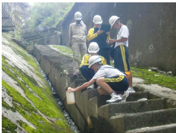
④漏水量調査
