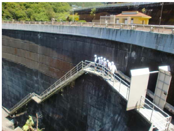
②ダム本体の点検
