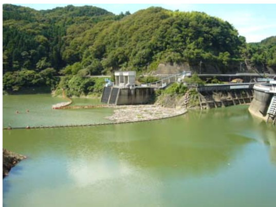
下流網場の流芥状況
