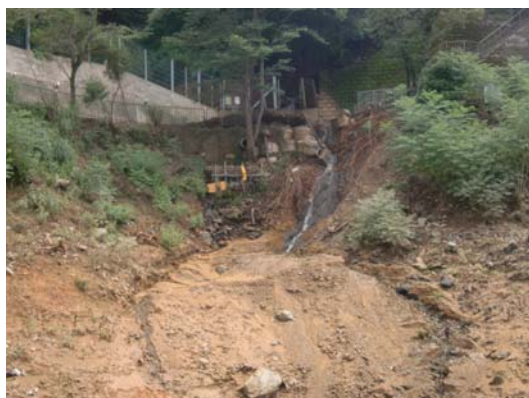
貯水池内への流入土砂 (ダムから200m上流付近(右岸))
