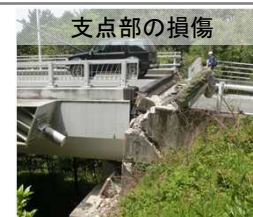
写真-6 熊本高森線 （桑鶴大橋）
