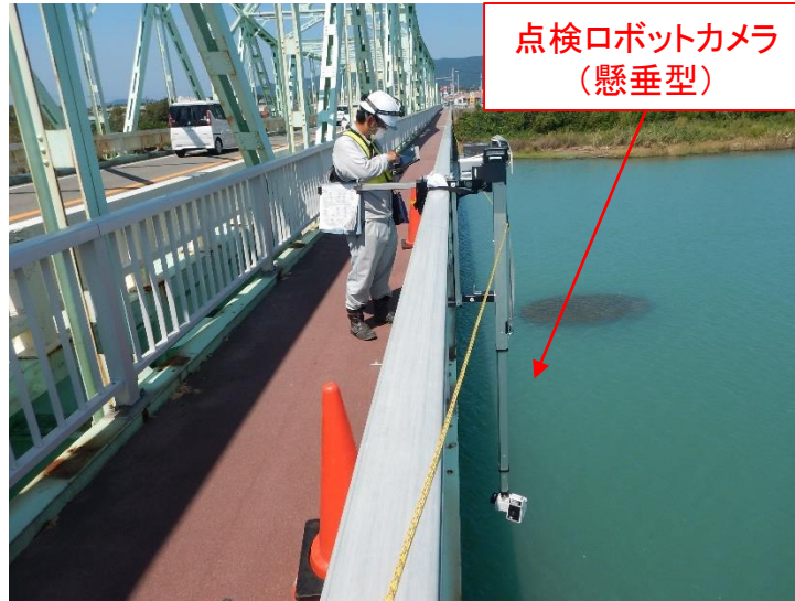
写真-1 点検状況
