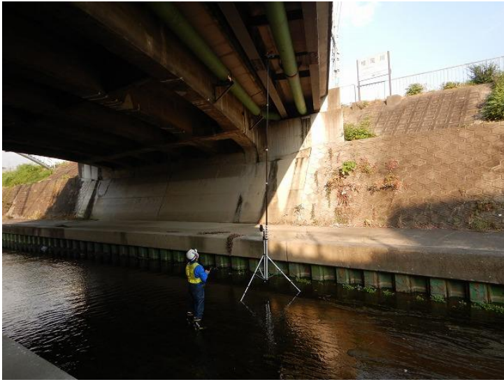
写真-1 点検状況
