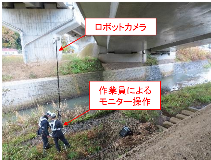
写真-1 点検状況
