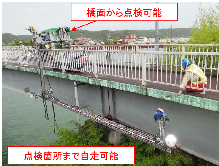
写真-1 点検状況
