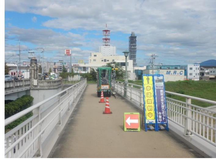
写真-2 交通規制状況
