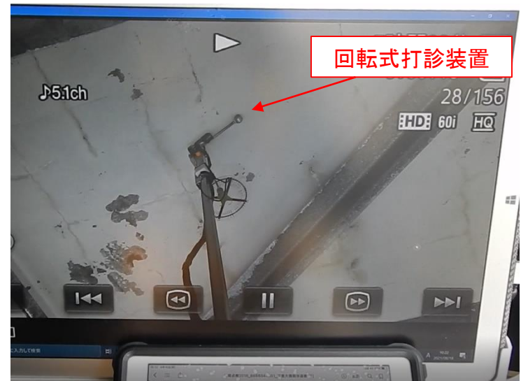
写真-2 撮影動画(打音検査時)
