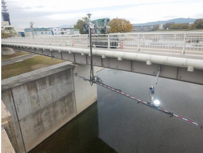
写真-1 点検状況
