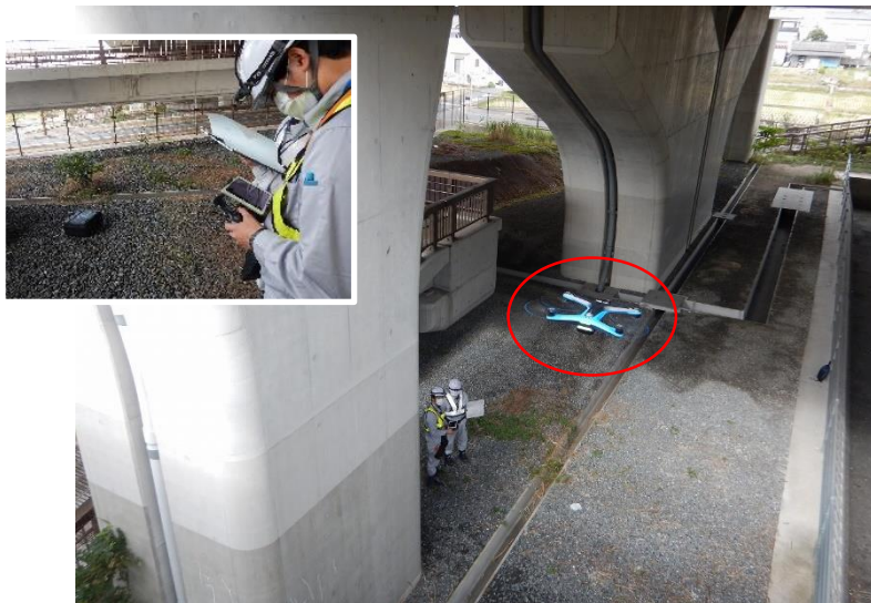
写真-1 点検状況
