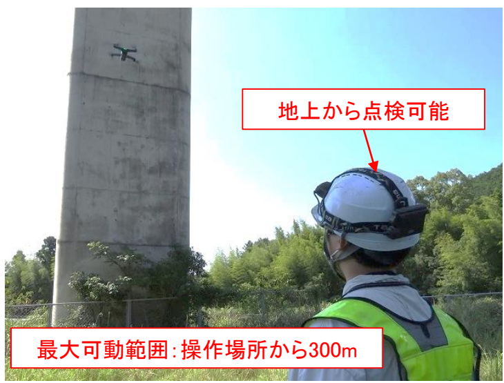
写真-1 点検状況
