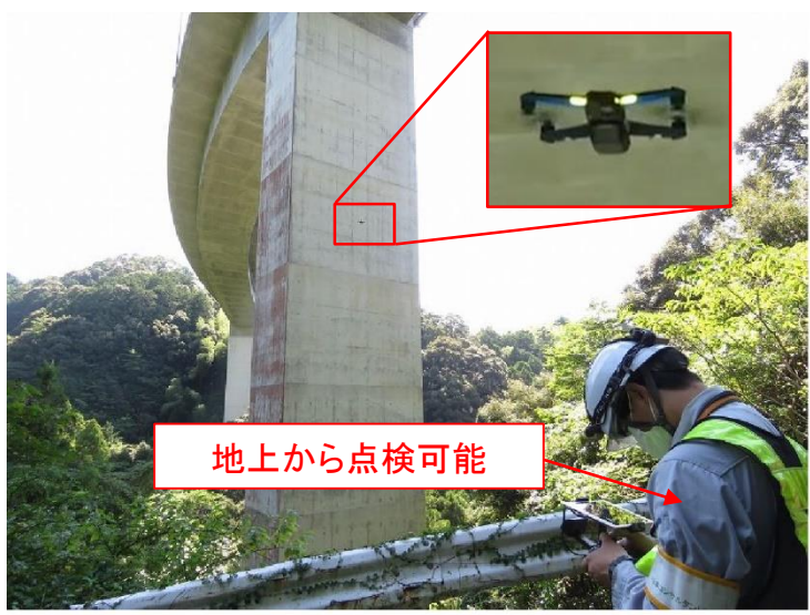
写真-1 点検状況
