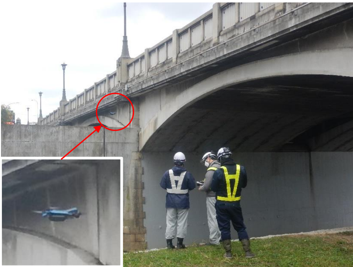
写真-1 点検状況
