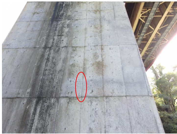
写真-3 柱(ひびわれ W=0.1mm:b)
