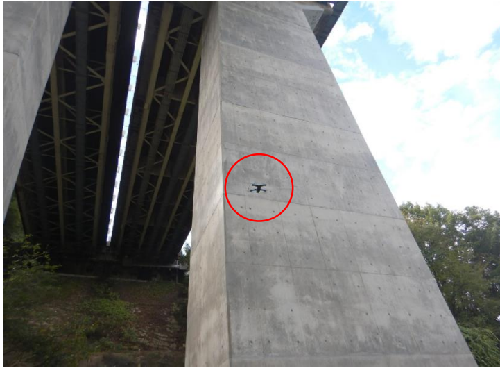
写真-1 ドローンによる撮影状況
