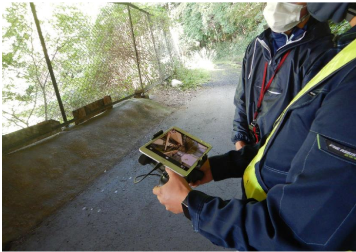
写真-1 ドローン操作状況
