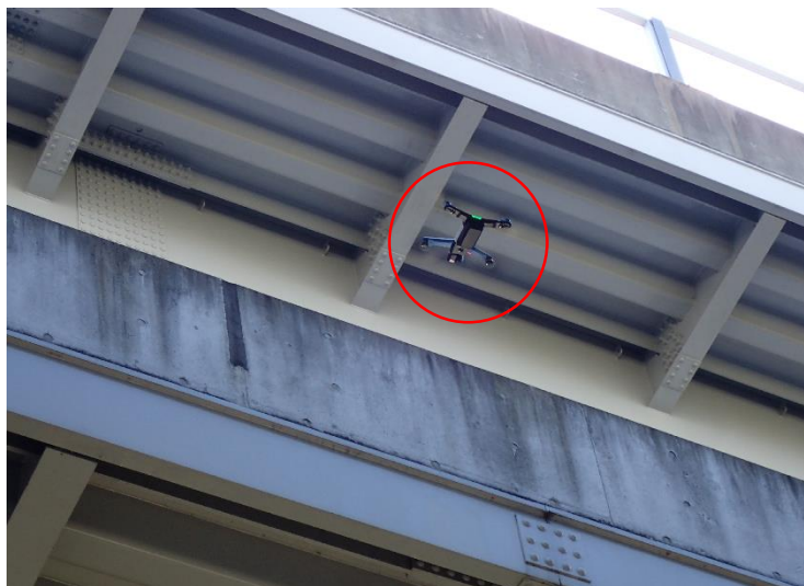
写真-1 ドローンによる撮影状況
