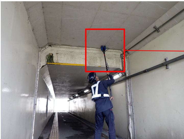
写真-3 点検状況(頂版)
