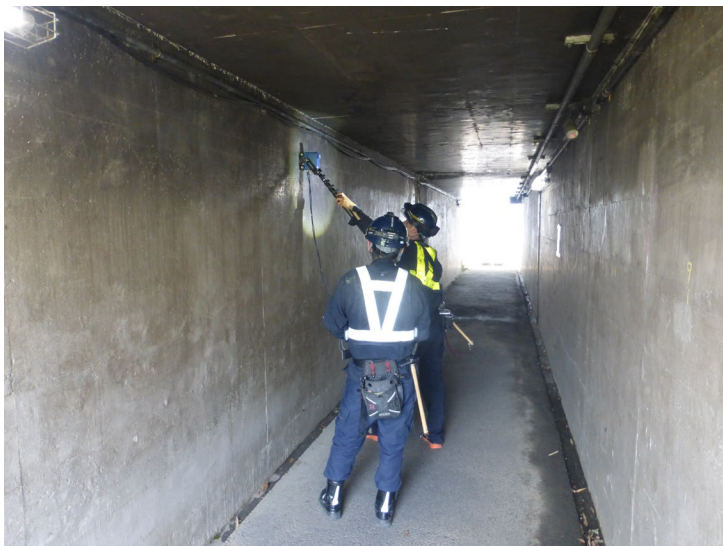
写真-1 点検状況(側壁)
