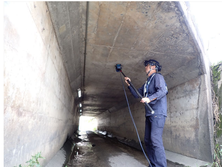
写真-2 点検状況(頂版)
