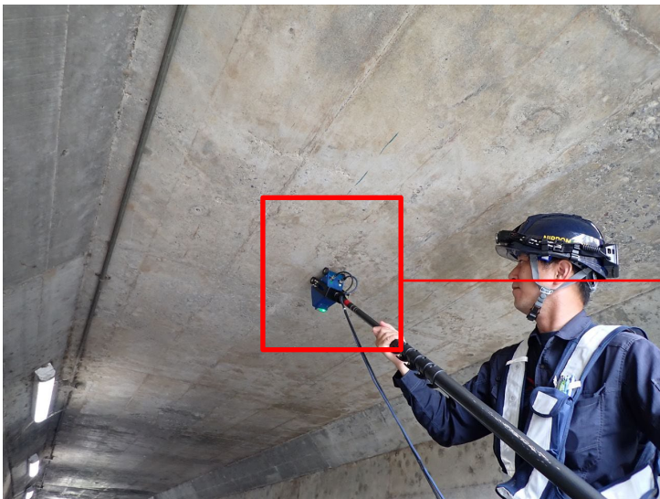
写真-3 LED点灯状況
