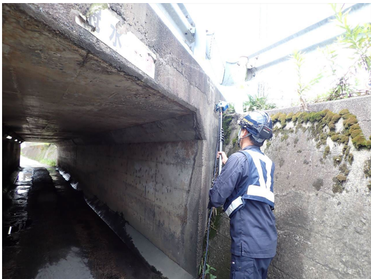
写真-1 点検状況(側壁)
