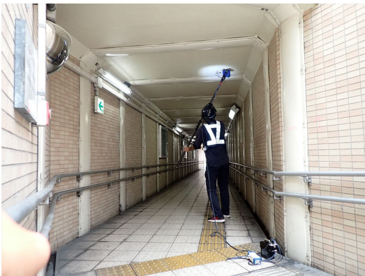
写真-3 点検状況(頂版)
