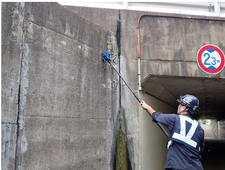
写真-1 点検状況
