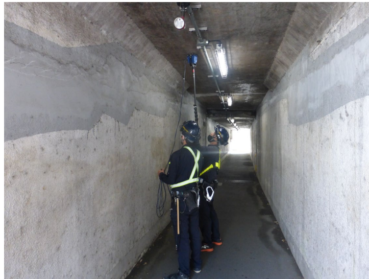
写真-2 点検状況(頂版)
