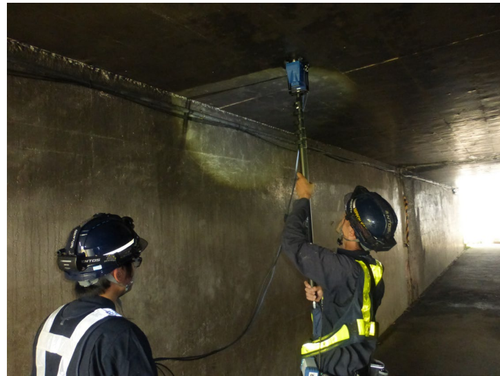
写真-2 点検状況(頂版)
