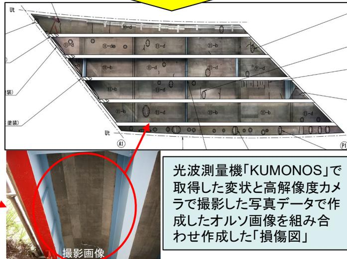
写真-4 高精度点検システムで作成した損傷図
