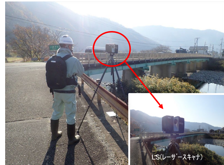
写真-2 3次元計測状況(地上部)
