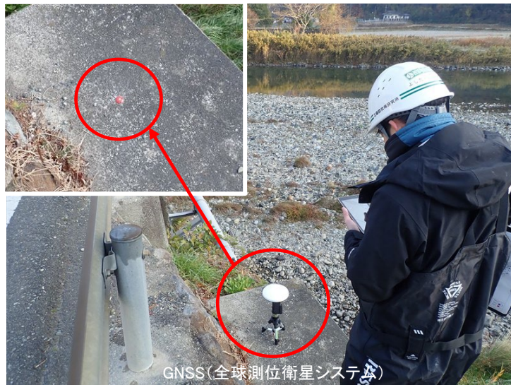
写真-3 GNSSを用いたKBM(仮ベンチマーク)設置
