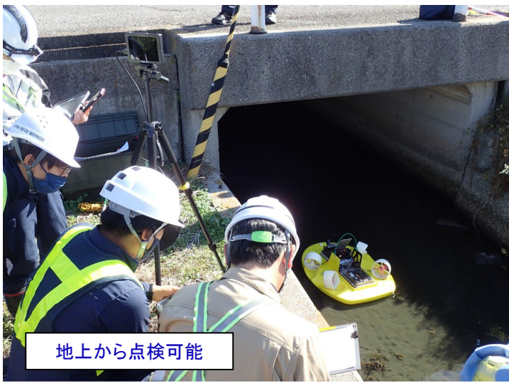
写真-1 点検状況
