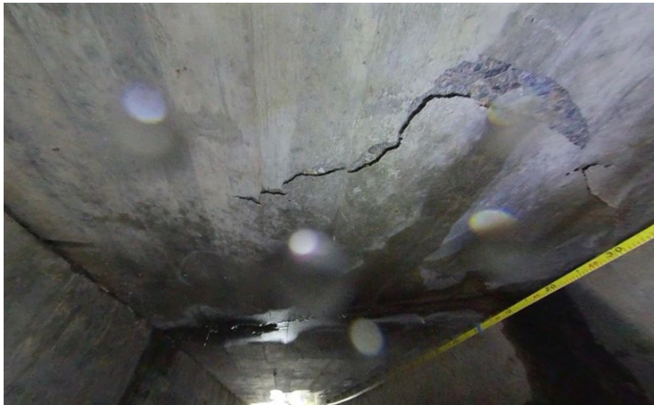
写真-3 主桁(うき:e)
