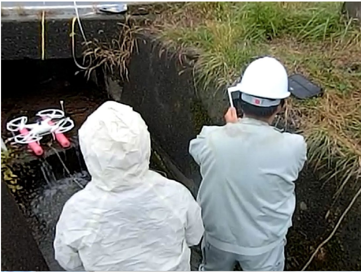
写真-1 点検状況
