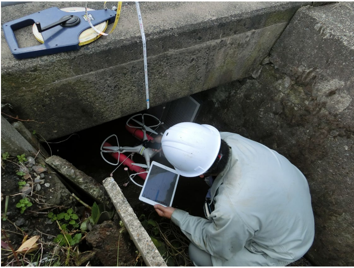
写真-1 点検状況
