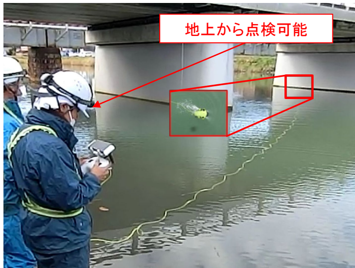
写真-1 点検状況
