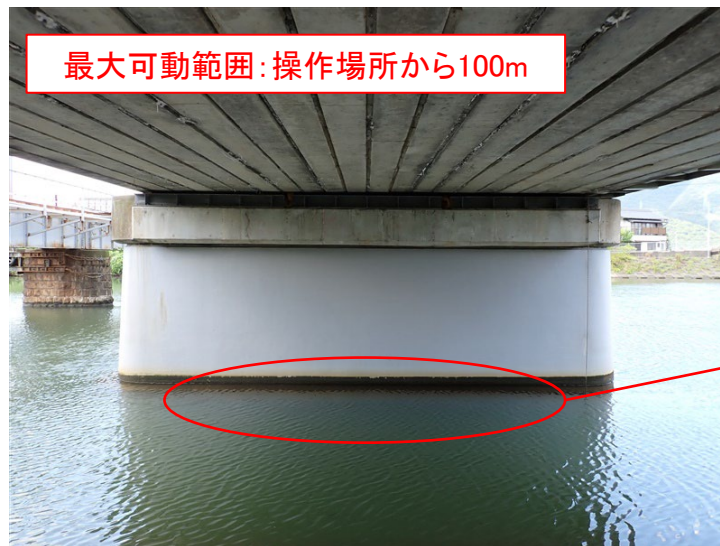
写真-3 点検対象橋脚の外観(水中部対象)
