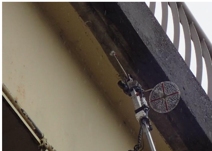
写真-3 打音状況
