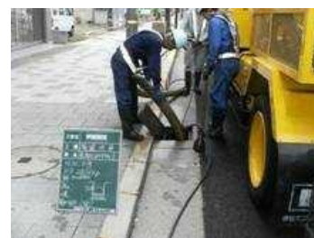
排水構造物清掃
