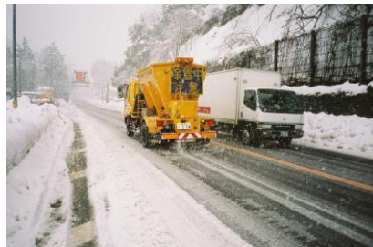
凍結防止材の散布作業
