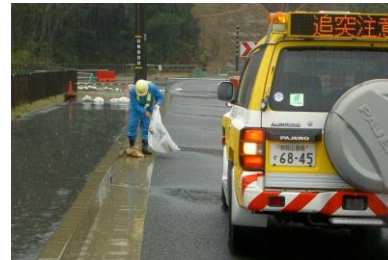
道路巡回（落下物の処理）
