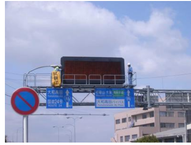
道路情報板の点検
